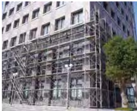
▲現在、外壁工事中の商工会議所会館
